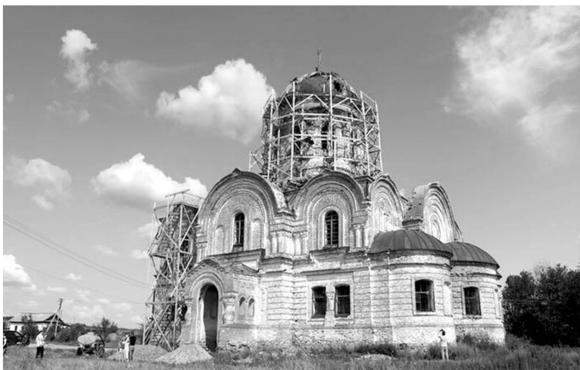
В 2013 году в историческом здании храма были начаты масштабные ремонтно-восстановительные работы.
