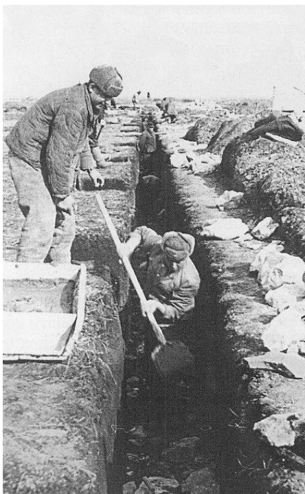
Бутовая кладка фундамента Компрессорной станции.
