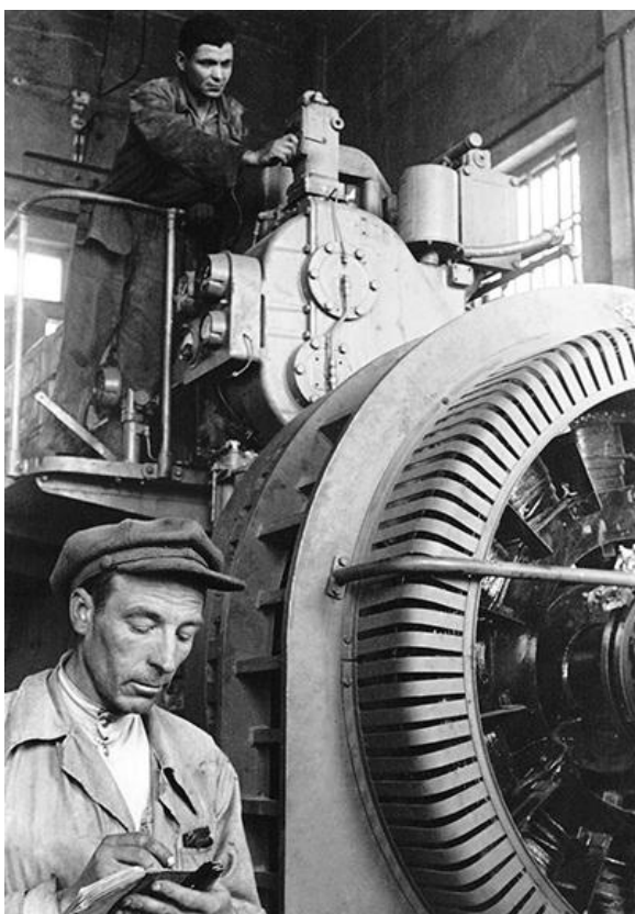
Мастер П.И. Кудасов на монтаже дизель – генератора на КС-1 газопровода Саратов – Москва. 1946 г.
