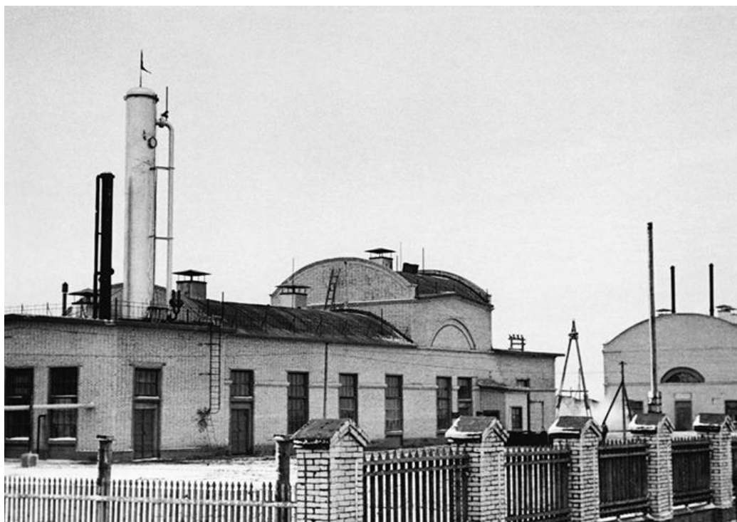
Компрессорная станция № 1 газопровода Саратов – Москва. Ноябрь 1946 г.
