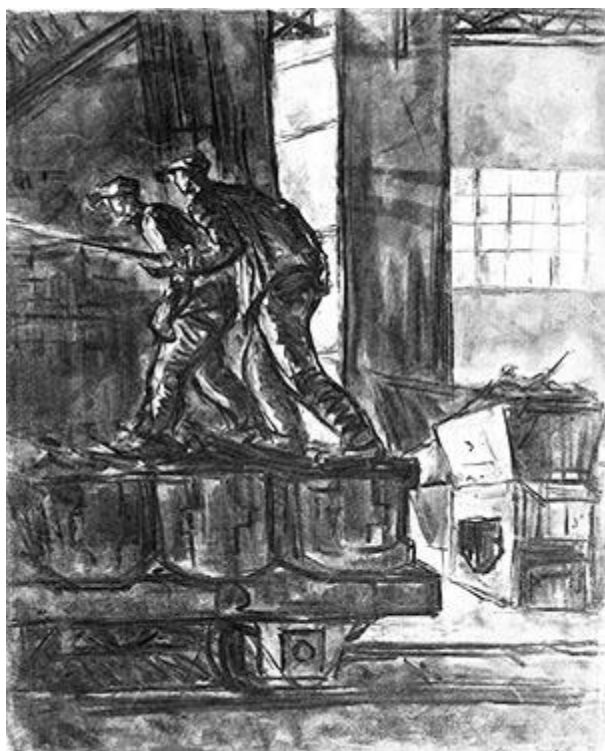
Заправка пролетов. 1937. Серия «Новый Донбасс (Макеевский металлургический завод им. Кирова)»
